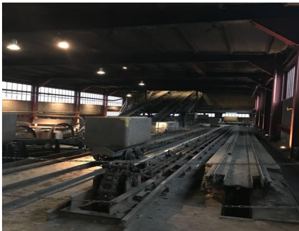
Blick in die Sortierhalle
