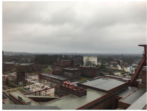
Ausblick vom Dach der Zeche Zollverein
